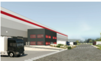
La future plateforme de 23 000 m 2 sera construite sur une ancienne friche industrielle. © DR
